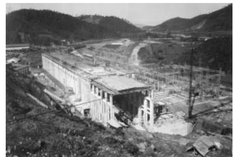
Construção da UHE Henry Borden em Cubatão, sem data.
