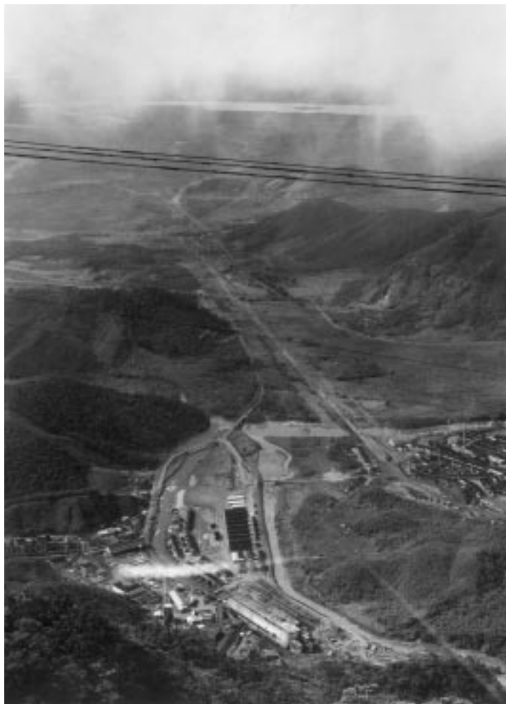
Vista da UHE Henry Borden e desnível da Serra do Mar, 1947.
