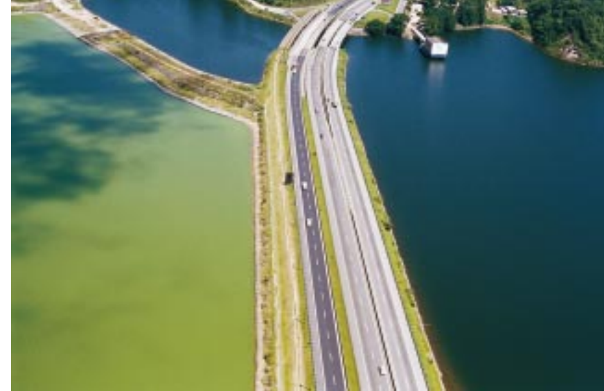
Barragem Anchieta que separa o Braço do Rio Grande do restante da Billings. (dez/99)
