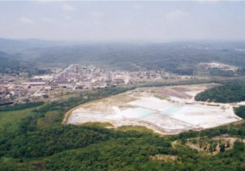
Área de mineração na região dos formadores do Braço do Rio Grande. (dez/99)
