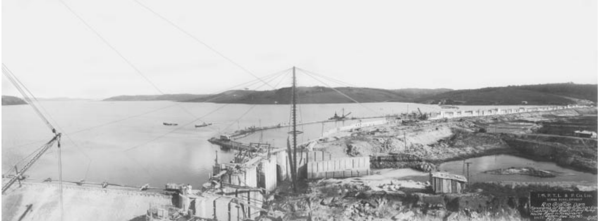
Construção da Barragem de Pedreira no curso do Rio Grande ou Jurubatuba, 1928.
