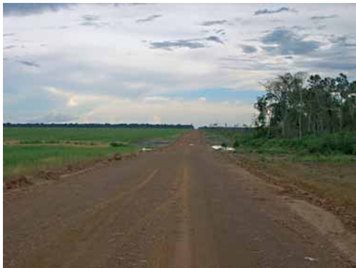
Aterro de estrada sobre córrego em Querência-MT.
