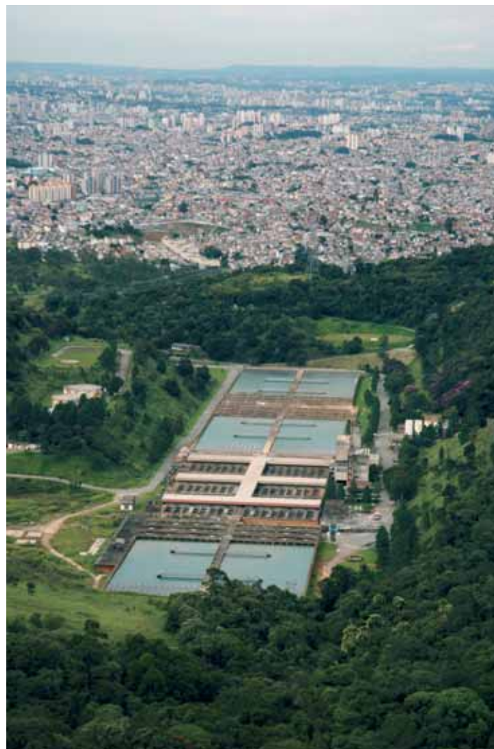
Estação de Tratamento de Água (ETA) do Guarauá, localizada no alto da Serra da Cantareira, e cidade de São Paulo ao fundo. Ali é tratada toda a água proveniente do Sistema Cantareira, que abastece metade da RMSP. Foto: latã Cannabrava/ISA (fev/07).
