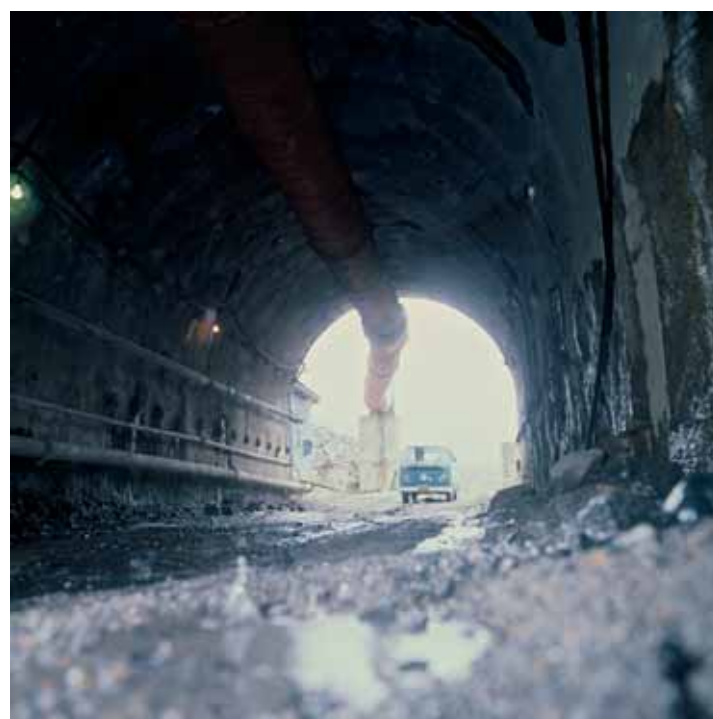
Túnel que integra o Sistema Cantareira em construção. Foto: Arquivo Sabesp.
