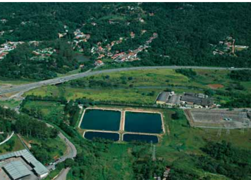
Estação de tratamento de esgoto (ETE) de Mairiporã, localizada na beira do canal do Rio Juquery, um pouco antes deste chegar ao reservatório Paiva Castro (o reservatório está à esquerda, logo após a rodovia Fernão Dias, que pode ser visualizada na foto). Foto: Iatã Cannabrava/ISA (fev/07).
