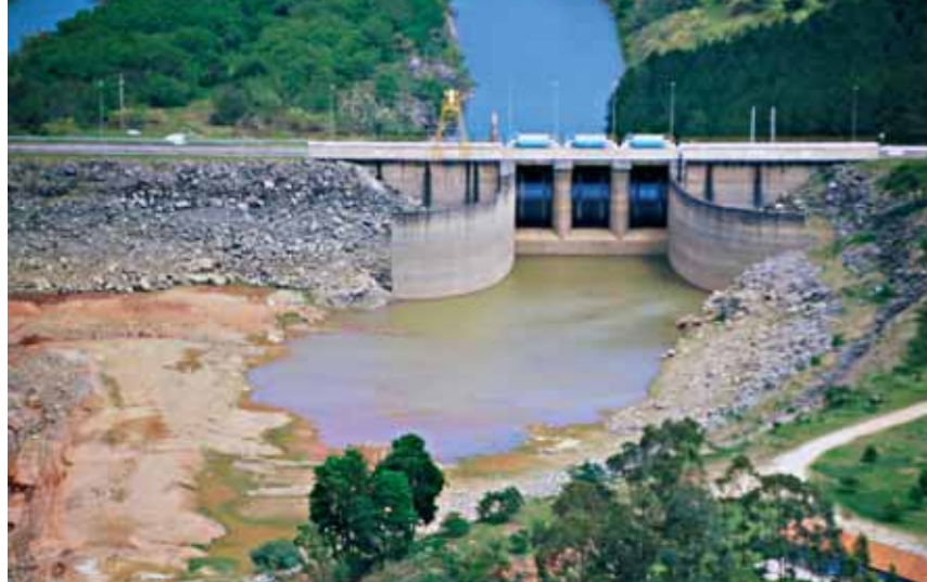
Barragem do Rio Jaguari com vista para jusante do reservatório, em período mais crítico da estiagem por qual passou a região. Foto: Iatã Cannabrava/ISA (dez/03)
