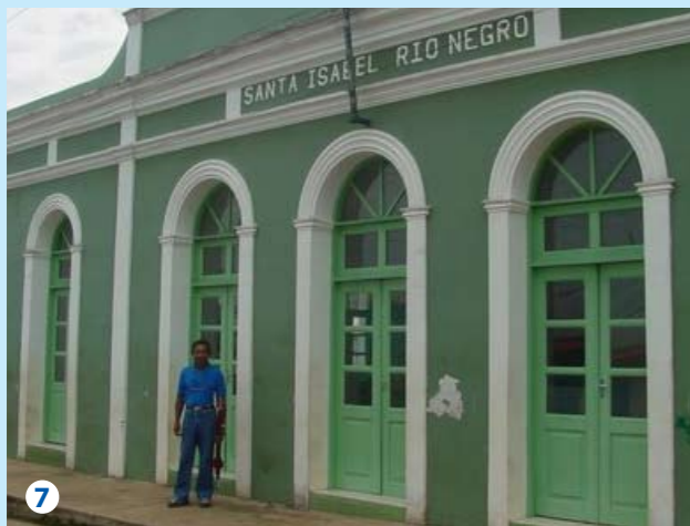
Fachada da Casa J. G. Araújo
