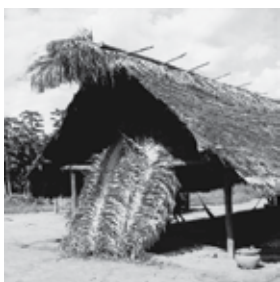
A cobertura desta casa, feita de folhas de ubim, dura vários anos e recebe cuidados permanentes para garantir sua impermeabilidade. Folhas de palmeira trançadas servem de biombo para proteger os moradores do sol e da chuva.
