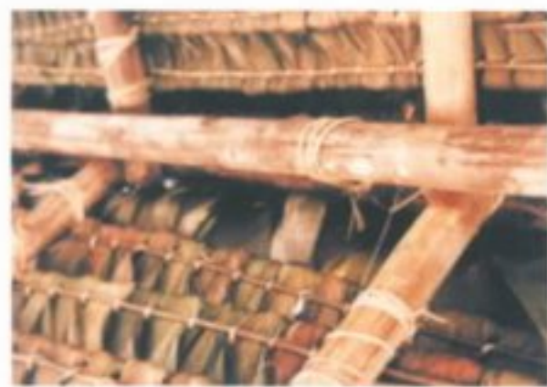
Vista interna da cumeeira.
