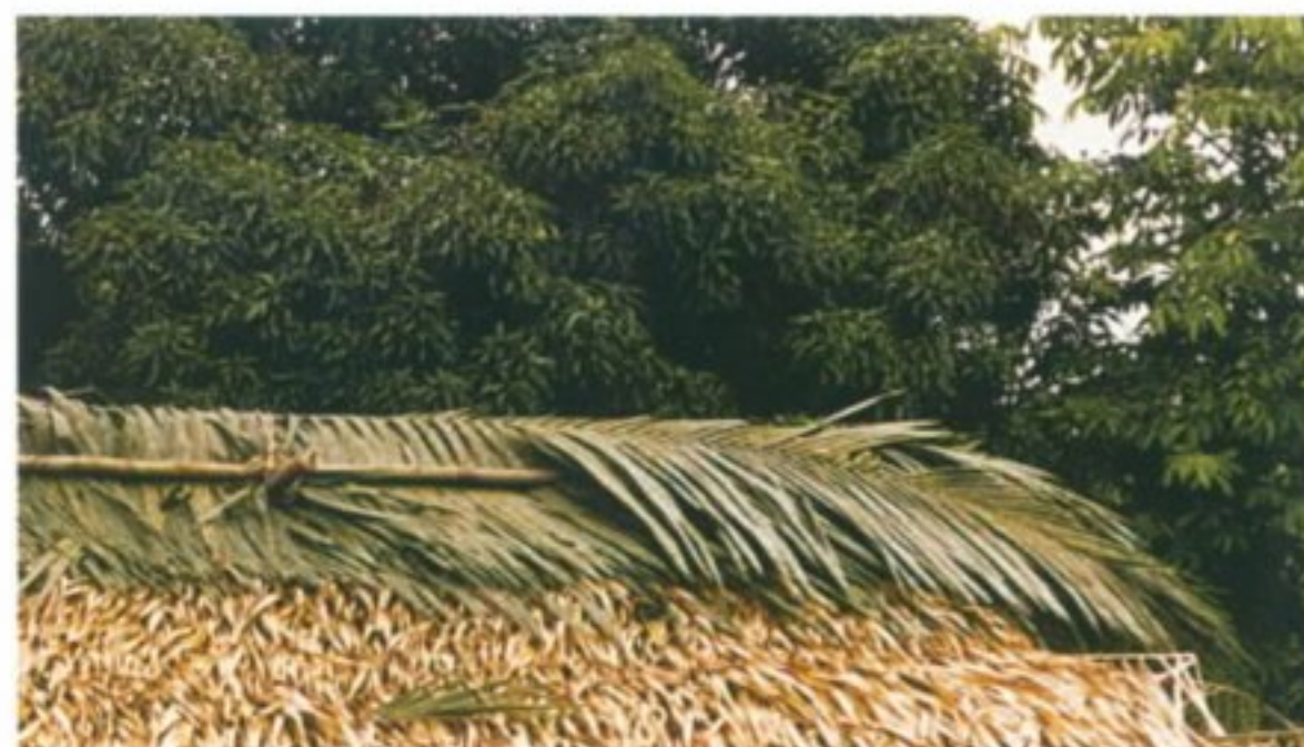
O acabamento está feito. Com o tempo, essas folhas de palha preta ficarão da mesma cor que o restante da cobertura.
