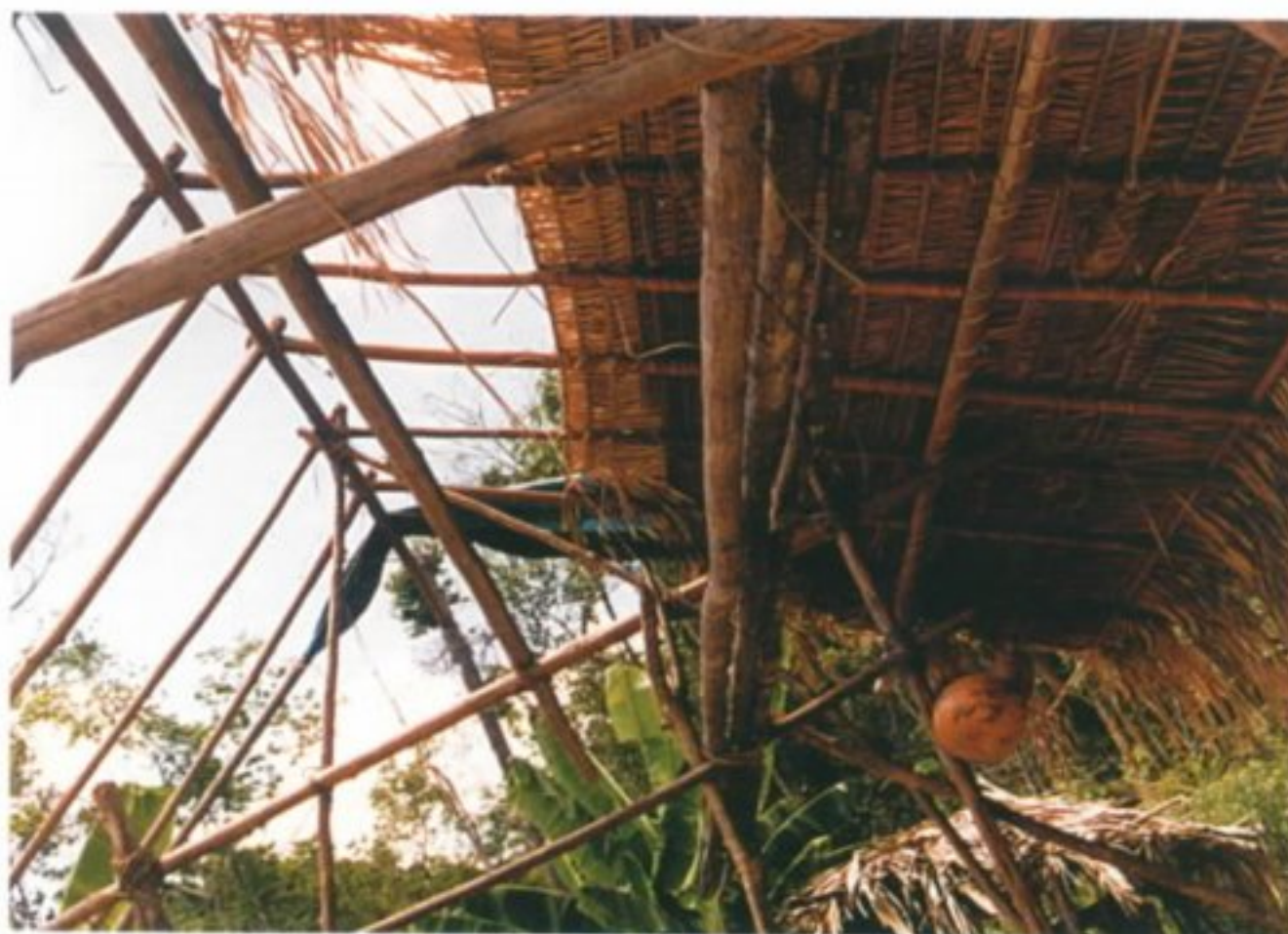
Cobertura em andamento, sem acabamento de cumeeira.
