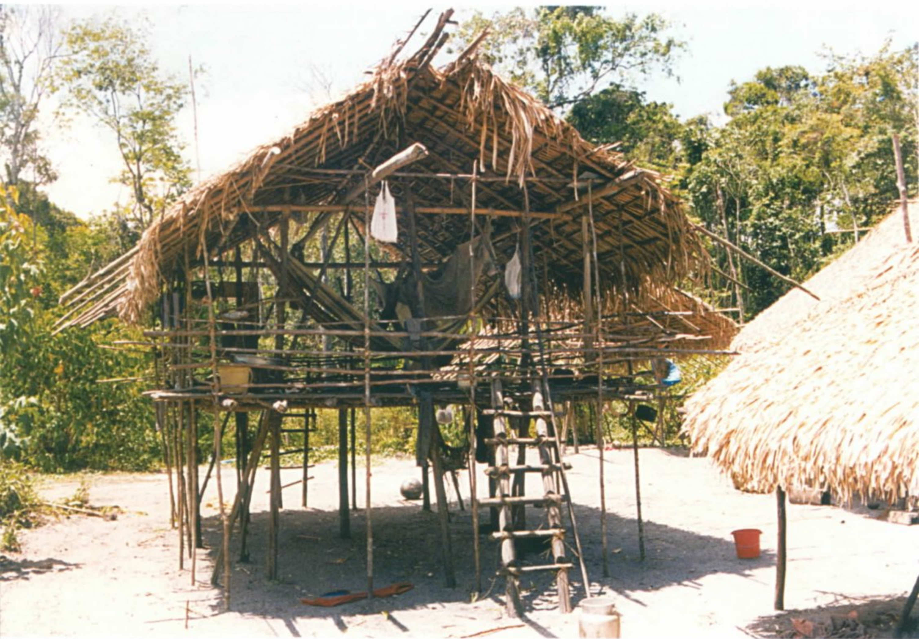
Casa jura de Sisiwa, com cobertura de palha preta.
