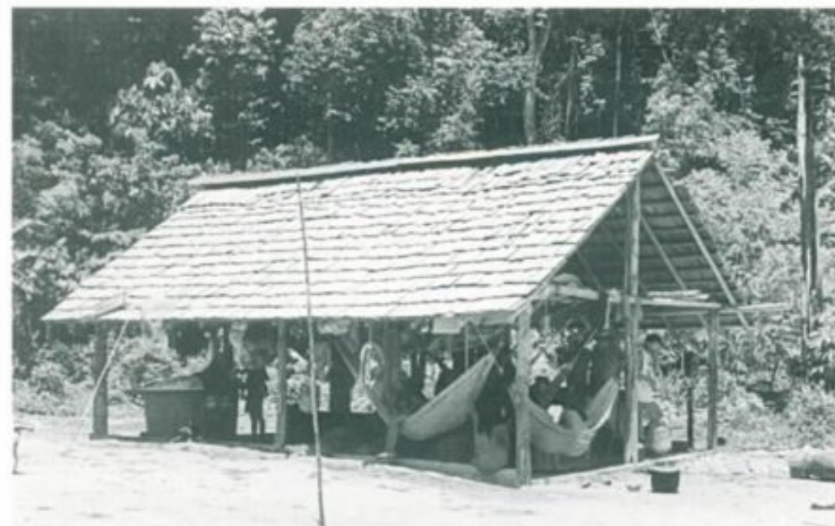
Casa neo-brasileira na aldeia CTA, construída com alicerce de concreto e telhas de madeira, com apoio de verbas da Administração regional da FUNAI. Funcionários de órgãos assistenciais têm incentivado a construção desse tipo de moradia, alegando poder ajudar na construção de "casas higiênicas", como propôs a Prefeitura de Pedra Branca aos moradores da aldeia Manilha. Esse tipo de casa, se for disseminado, será certamente mais um importante fator de sedentarização e perda de qualidade de vida, como acúmulo de lixo, poluição dos rios, esgotamento de recursos naturais e empobrecimento dos solos para roças.
