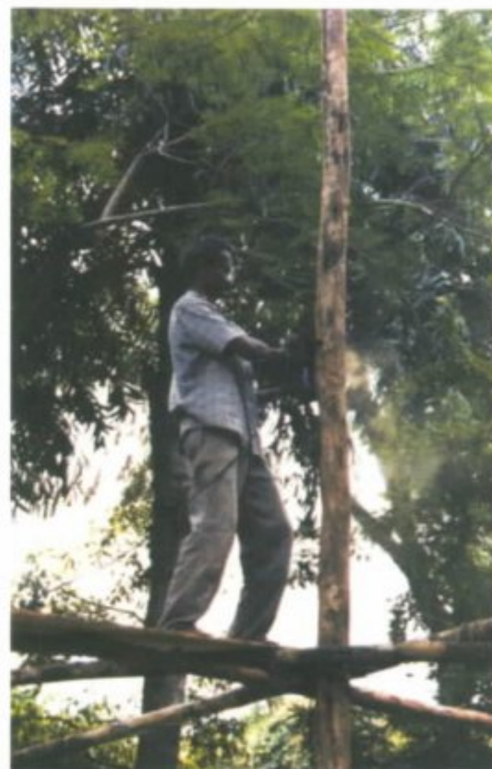
Cortando o excesso de pilar.
