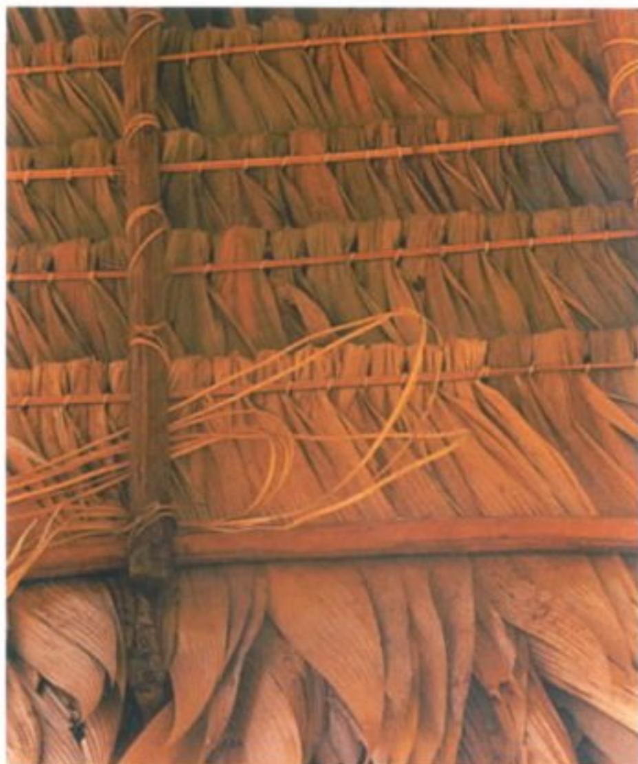
Vista interna de cobertura de ubim.
