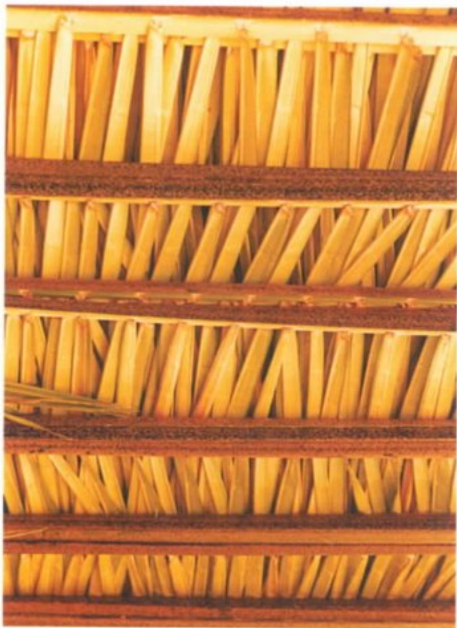
Vista interna de cobertura de palha preta.
