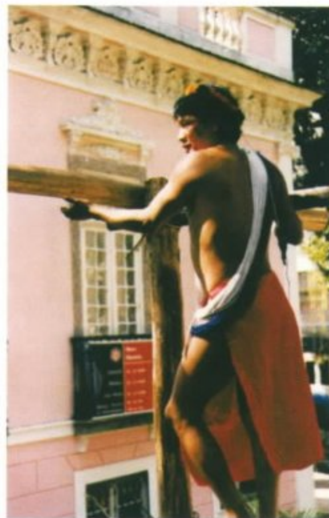
Noe nivelando as vigas.
