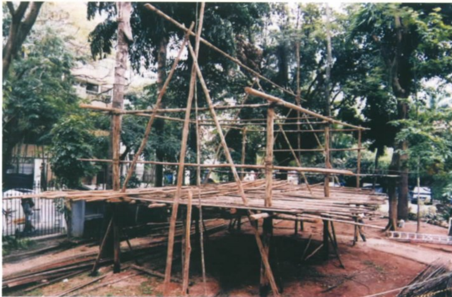
Vista da estrutura quase pronta, faltando a segunda cumeeira.
