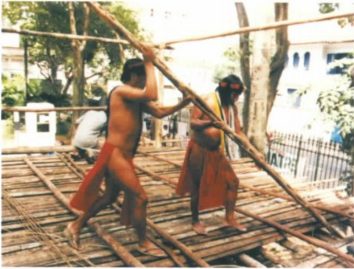
Noe e Emyra posicionando um esteio okapy kā'gwer rena .
