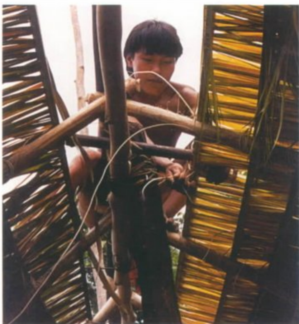
Colocação do kamarijô entre as duas vigas de cumeeira.
