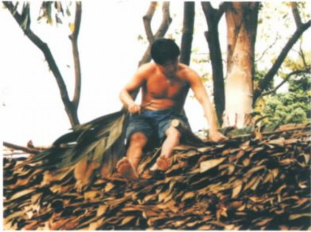
Noe colocando folhas de ubim para proteção das cumeeiras, como substituição do kamarijô .
