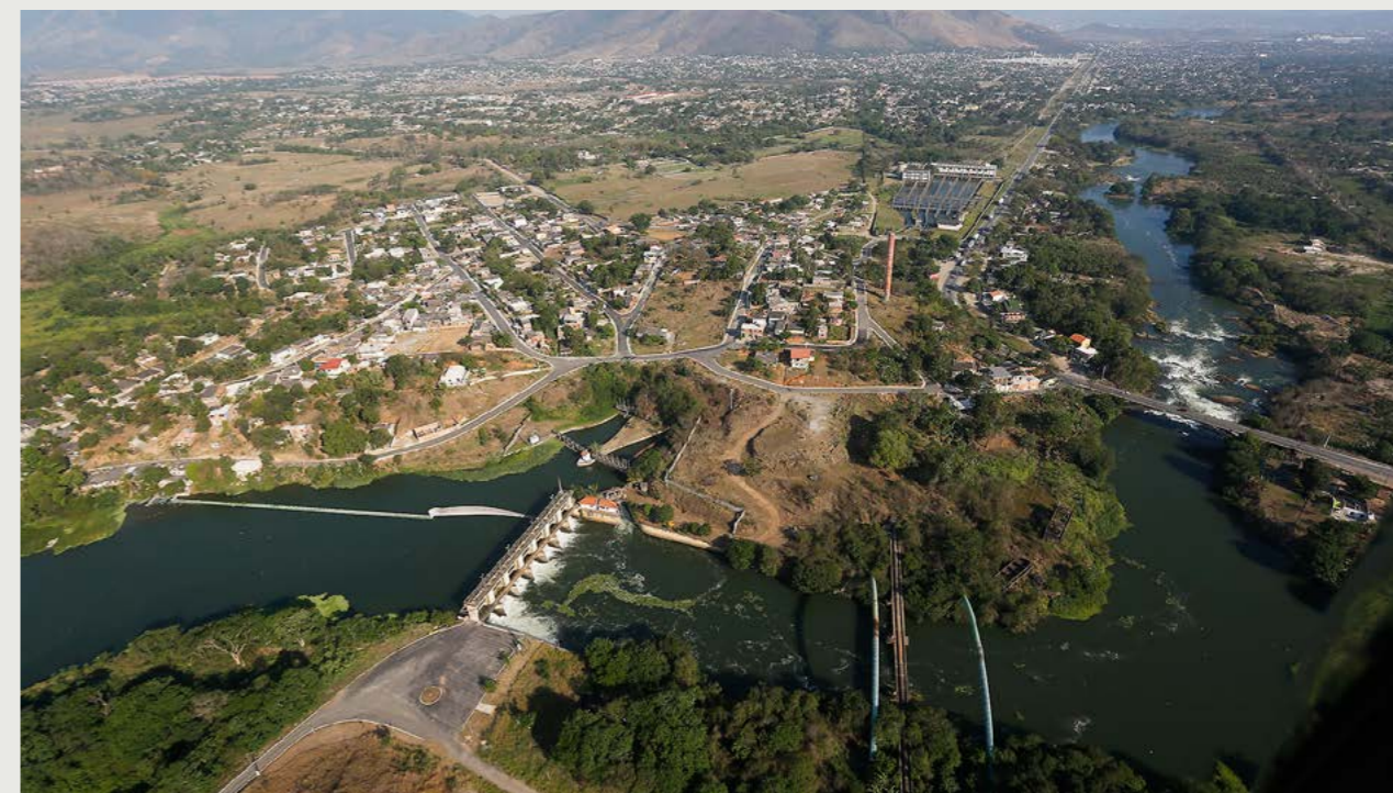
Sistema de captação de água do Guandu, responsável pelo abastecimento da Região Metropolitana do Rio de Janeiro. Única fonte para abastecimento de água, expõe fragilidade do sistema já intensamente degradado. Foto: Custodio Coimbra.
