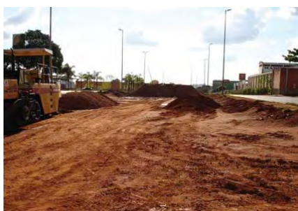
Terraplenagem nas vias marginais de Uberlândia
