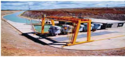
Vista parcial da E.B. - 2
