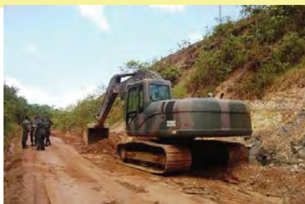
Terraplenagem km 99 - Santarém - Rurópolis
