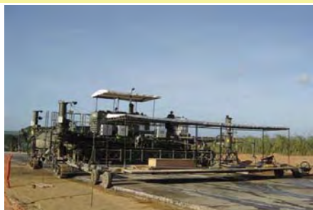
Máquina acabadora de concreto
