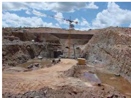
Escavações e obras da casa de força
