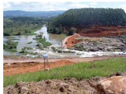
Construção da ensecadeira para desvio do rio
