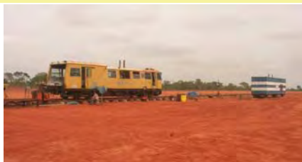
Lançamento de trilhos no Km 272
