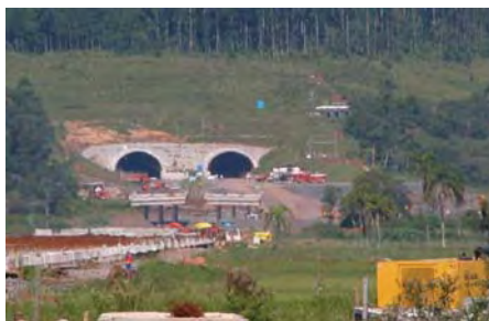
Emboque norte do túnel do Morro Alto
