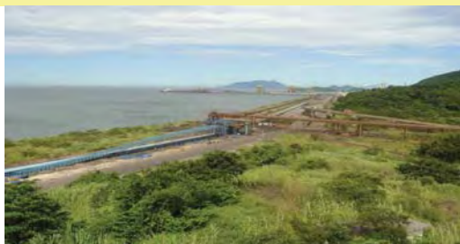
Vista do canal de acesso ao Porto
