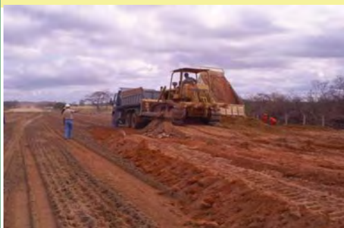
Terraplenagem em Missão Velha/CE
