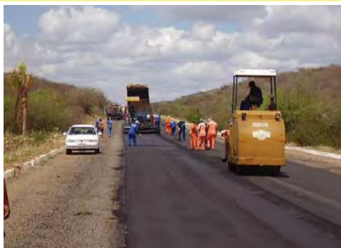
Restauração em execução
