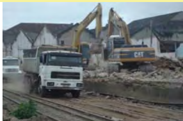
Demolição de armazém 28
