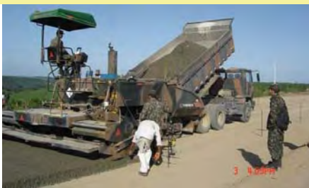
Execução de base de concreto de cimento rolado
