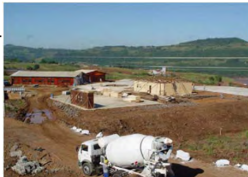
Vista canteiro de obras
