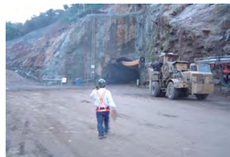
Escavação do túnel de adução
