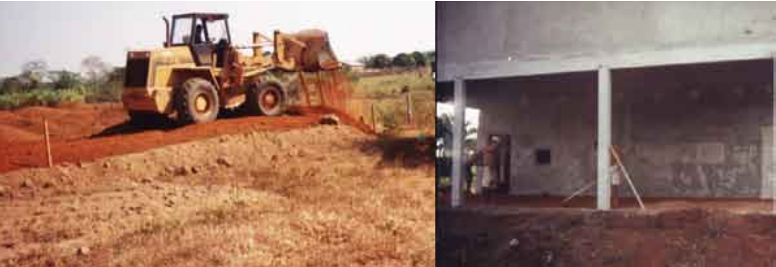
■ Terra-planagem da área da fábrica de polpas de frutas (hoje 60% construída)
