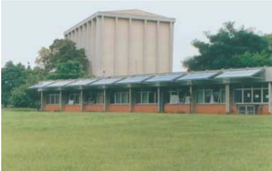
Figura 6. Sistema fotovoltaico de 12kWp integrado a fachada do IEE-USP.
