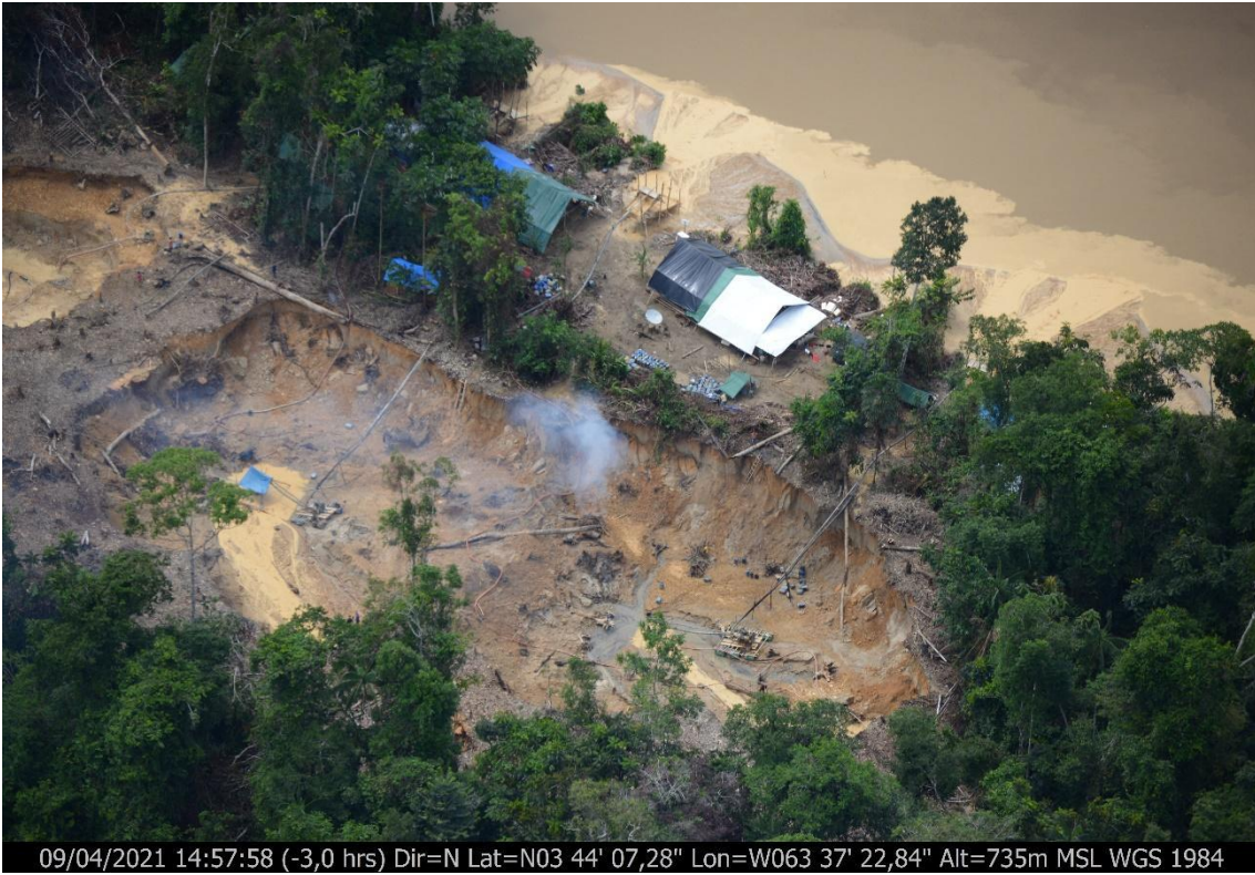
Foto 56 – Acampamento e canteiro no rio Uraricoera
