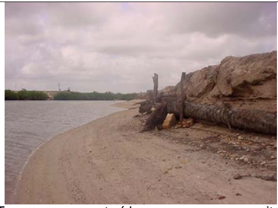
Tanque construído sem respeitar distanciamento do rio previsto pela legislação vigente (Res. CONAMA 303/02).
