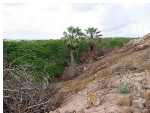
Talude alto, desmatamento de APP e material sendo carreado ao mangue e rio.
