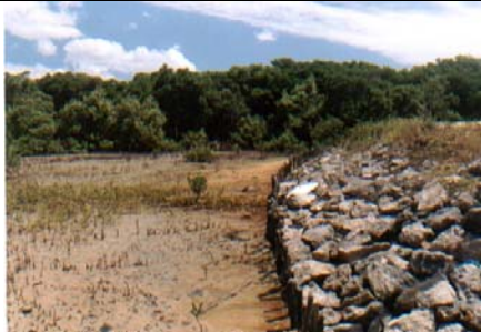
Talude sobre terrenos de mangue e em setores de exutório do lençol freático. (Foto de Jeovah Meireles, rio Acaraú)
