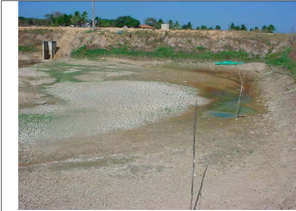
Tanque com sinais de utilização recente, descumprindo o termo de embargo.
