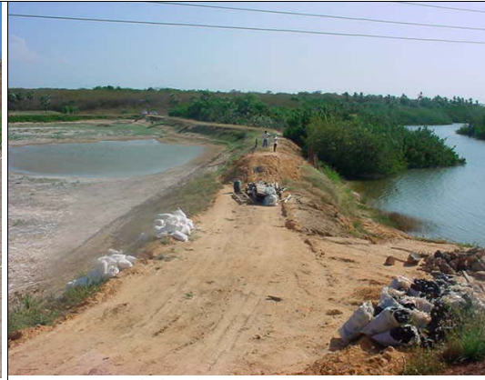
Vista parcial do tanque embargado, mostrando nítida a utilização de APP.
