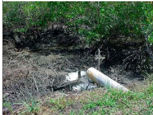
Além de não possuir distanciamento adequado do manguezal, este projeto lança seus efluentes diretamente no manguezal.
