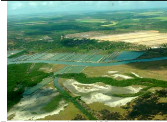
Tanques implantados em APP de rio.
