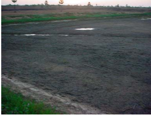
Vista parcial do empreendimento (instalado e não operando).
