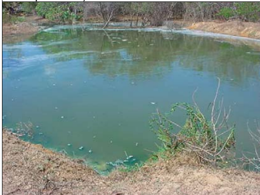
Bacia de decantação dos efluentes do beneficiamento. Construção precária e mal dimensionada, com vazamento para áreas adjacentes acarretando morte de vegetação. Forte cheiro de enxofre, provavelmente devido à presença de metabissulfito de sódio (conservante).
