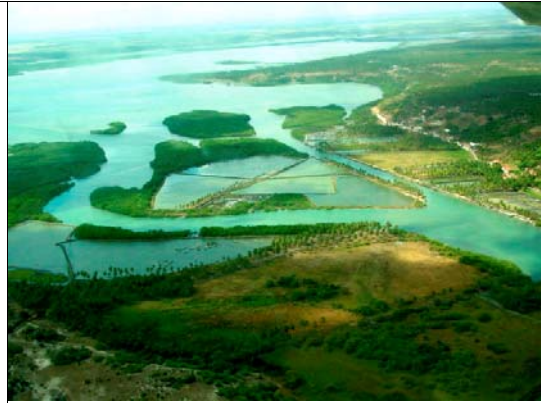
Tanques implantados em ilha no estuário.
