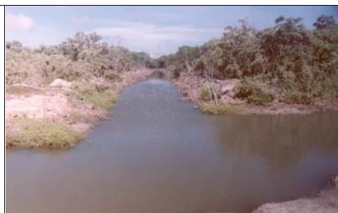
Desmatamento do manguezal para implantação de canal de adução e deságüe de efluentes. (Foto de Jeovah Meireles, rio Aracatimirim, área de influência da Terra Indígena Tremembé).
