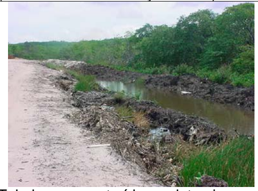
Taludes construídos laterais ao manguezal. Podemos ver a deposição de detritos dessa área (foto do Relatório de março de 2003)
