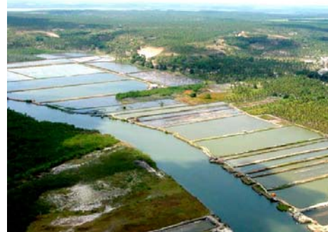
Tanques implantados totalmente em APP, sem distanciamento do rio.
