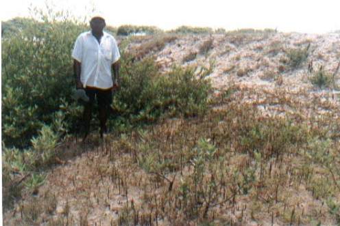
Construção de diques diretamente sobre o ecossistema manguezal; assoreamento por erosão dos taludes. (Foto de Jeovah Meireles, rio Acaraú)
