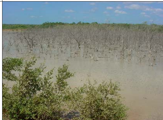
Vista de tanque embargado. Os taludes foram construídos em manguezal, isolando parte deste no interior do tanque, e sua morte.
