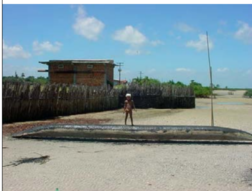
Projeto construído lateralmente na planície de maré. Sem bacia de sedimentação, e com descarte direto dos efluentes.
