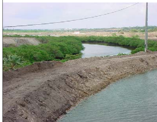
Viveiro construído na APP do rio Jundiá.
