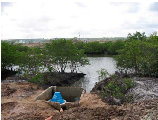
Canal de aproximação e ponto de captação construído em manguezal.
