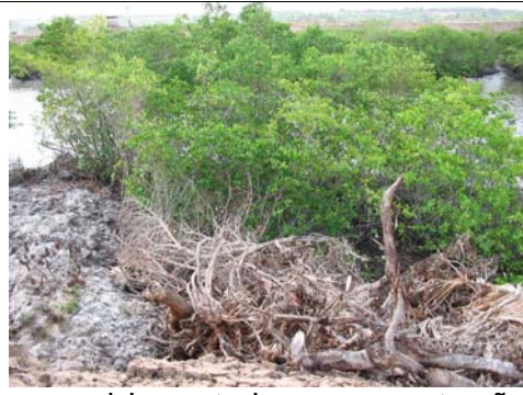
Manguezal impactado para construção de taludes.
