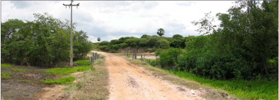
Estrada de acesso ao empreendimento cruzando área de manguezal. A passagem se deu sobre uma gamboa, a água que passa ao manguezal localizado à esquerda por meio de tubulação. (Evandro Ribeiro Lima). Rio Jaguaribe.
