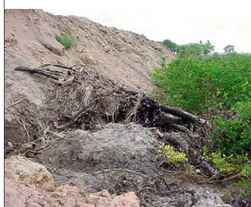
Talude sem recuo do manguezal, causando o seu assoreamento e entulhamento.
