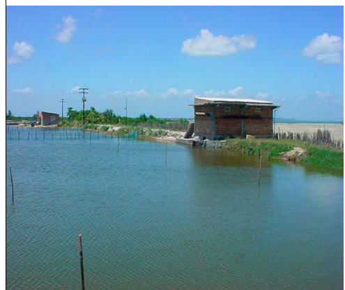
Taludes dos viveiros instalados sem devido recuo do manguezal.
