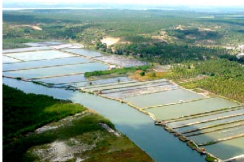
Mortandade de mangue adjacente a tanques.
