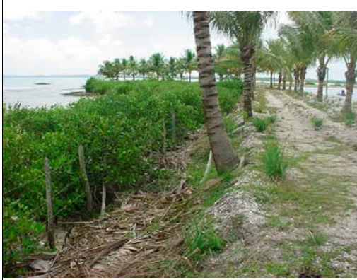
Talude sem distanciamento do manguezal, com entulho em suas bordas.
