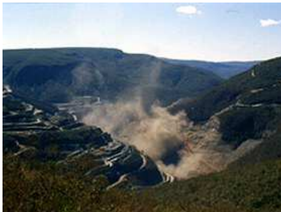
Obras da barragem de Irapé-MG
