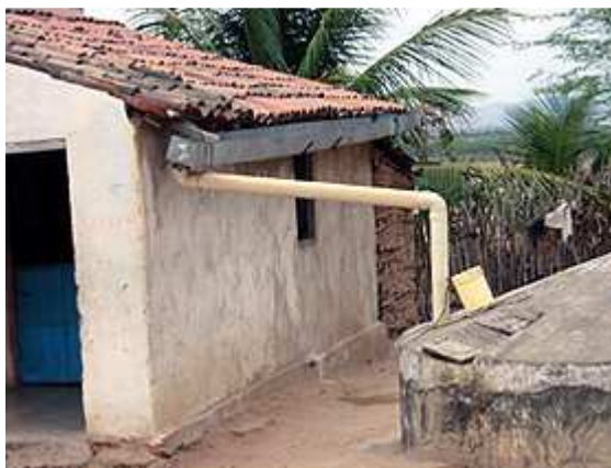
Cisterna construída em aldeia indígena
