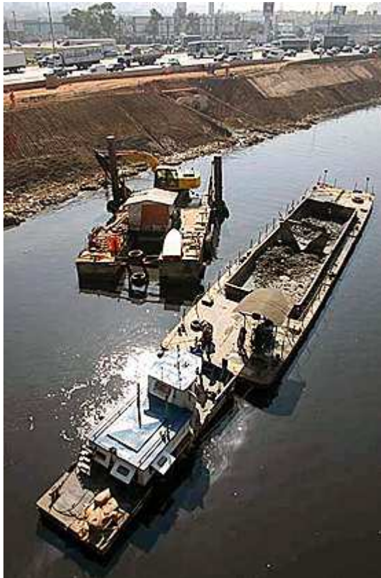
Obras de revitalização do Rio Tietê
