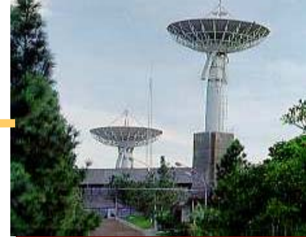
Estação recepção Cuiabá/MT
