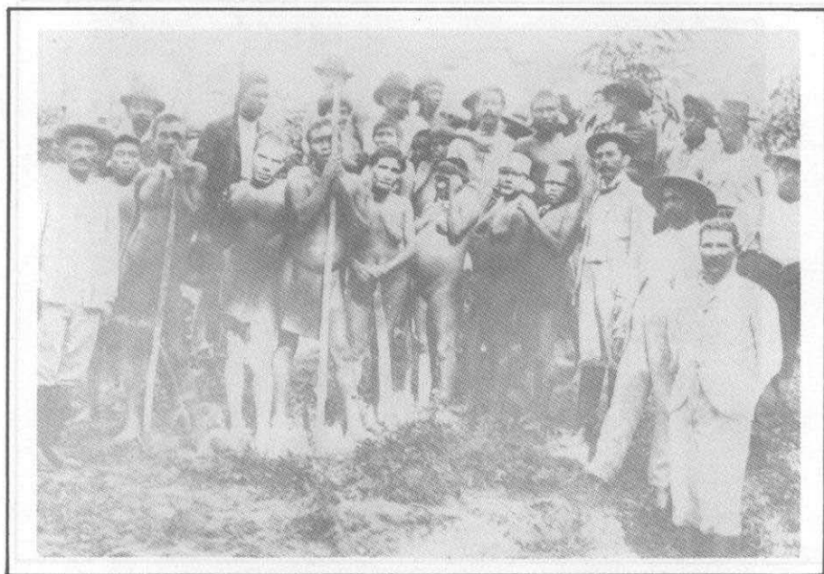
9: Estrada Vitória-Minas na região do Vale do Rio Doce. Foto: Engenheiro Emilio Bello de Mello Cunha.
