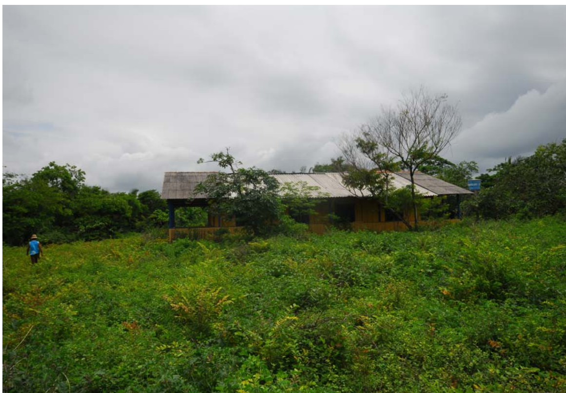
Ponto F – E, na mesma condição está a casa sede, onde até 1996, hospedava-se JV e depois, a partir de 1997, serviu como base de apoio aos empregados de Osmar Ferreira.
