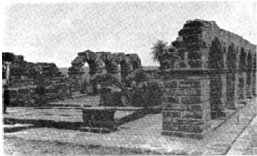
36. Arcos de las casas de indios, en Trinidad. "Un pórtico de tres brazos, bajo el cual se podía recorrer a cubierto la ciudad, defendía del sol y de la lluvia las puertas y fachadas de las casas" (Peramás 1946: 26). Foto Blanch
