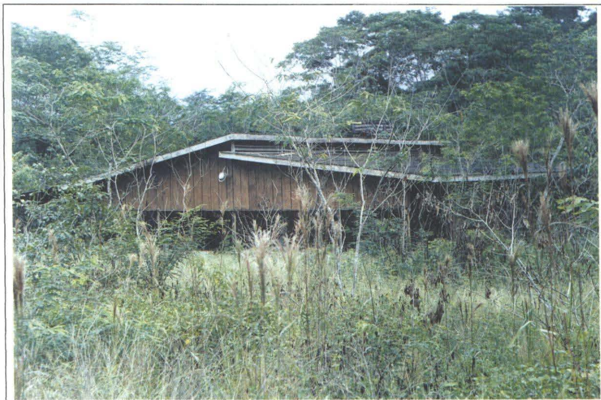
Foto 12 - construções abandonadas pela mineração
