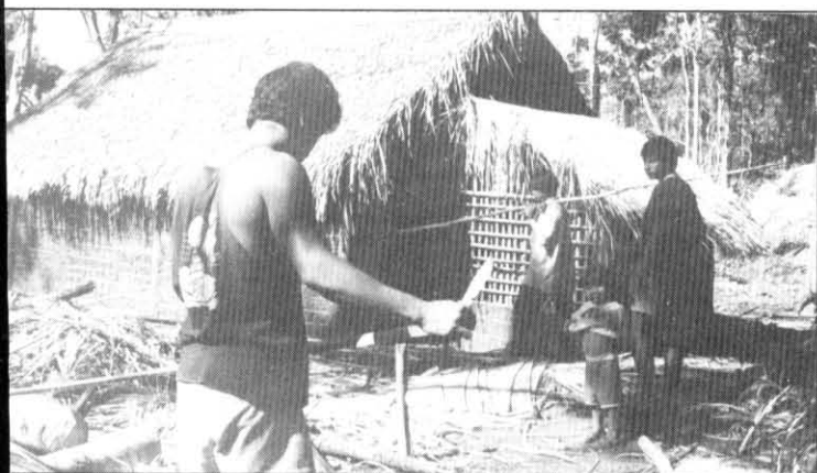
Construção de casa de frente para o sol nascente Aldeia Guarani
