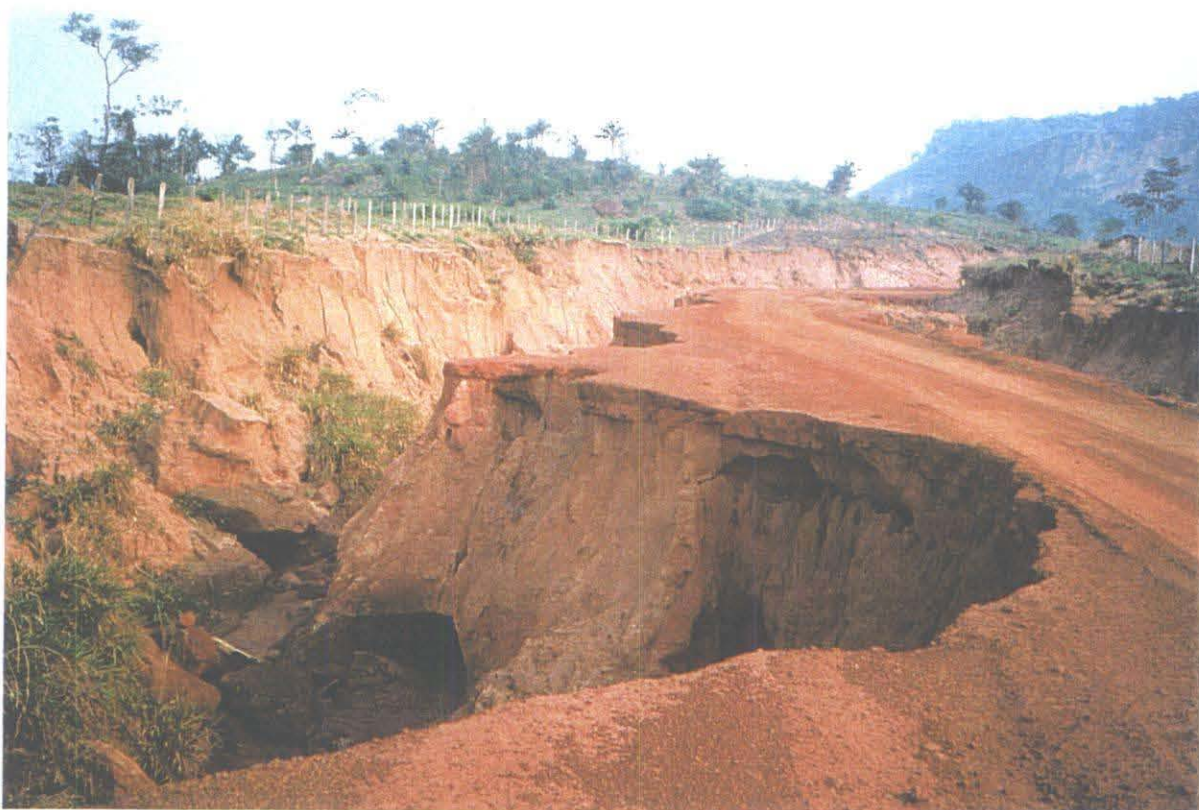
Voçoroca nas beiras da rodovia Tangará da Serra - Deciolândia
