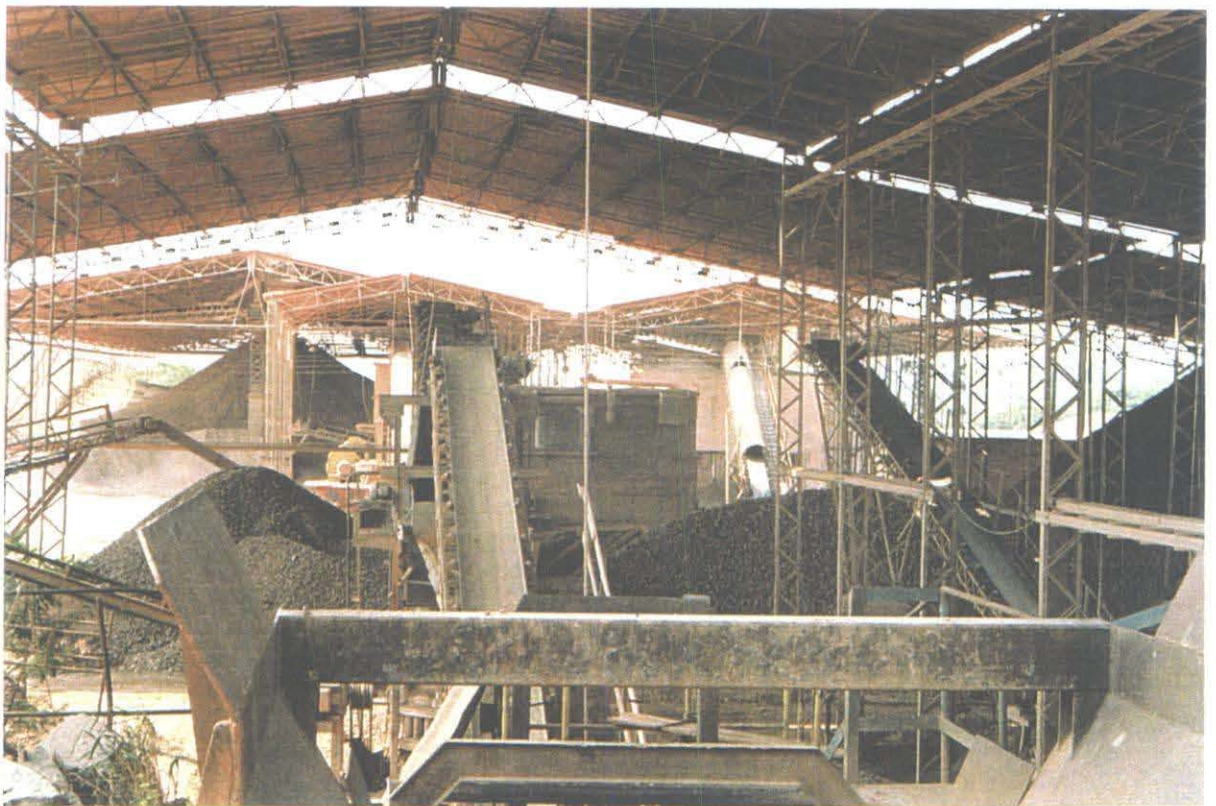
Usina de processamento de calcário
