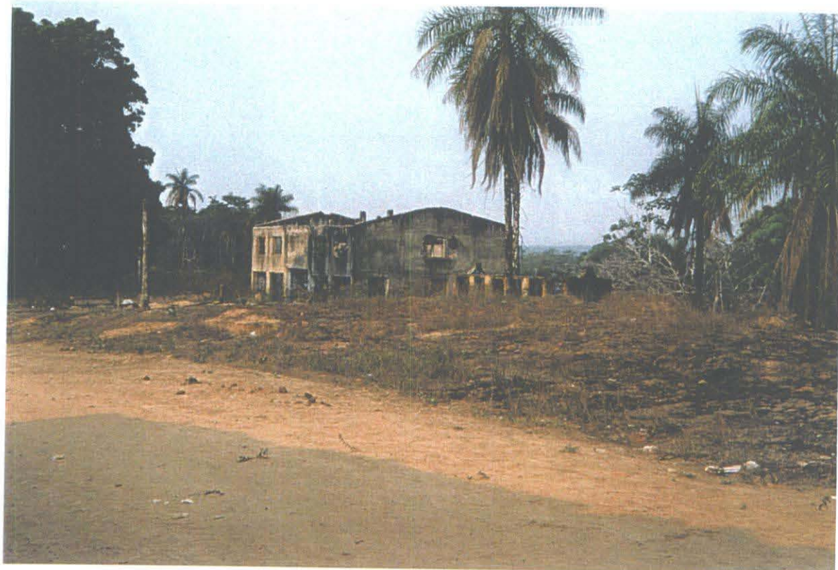
Ruína do depósito de cereais, do descascador e da oficina Utiariti
