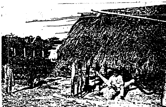
Fig. 10. — Casa de Paressís en Utiáriti
