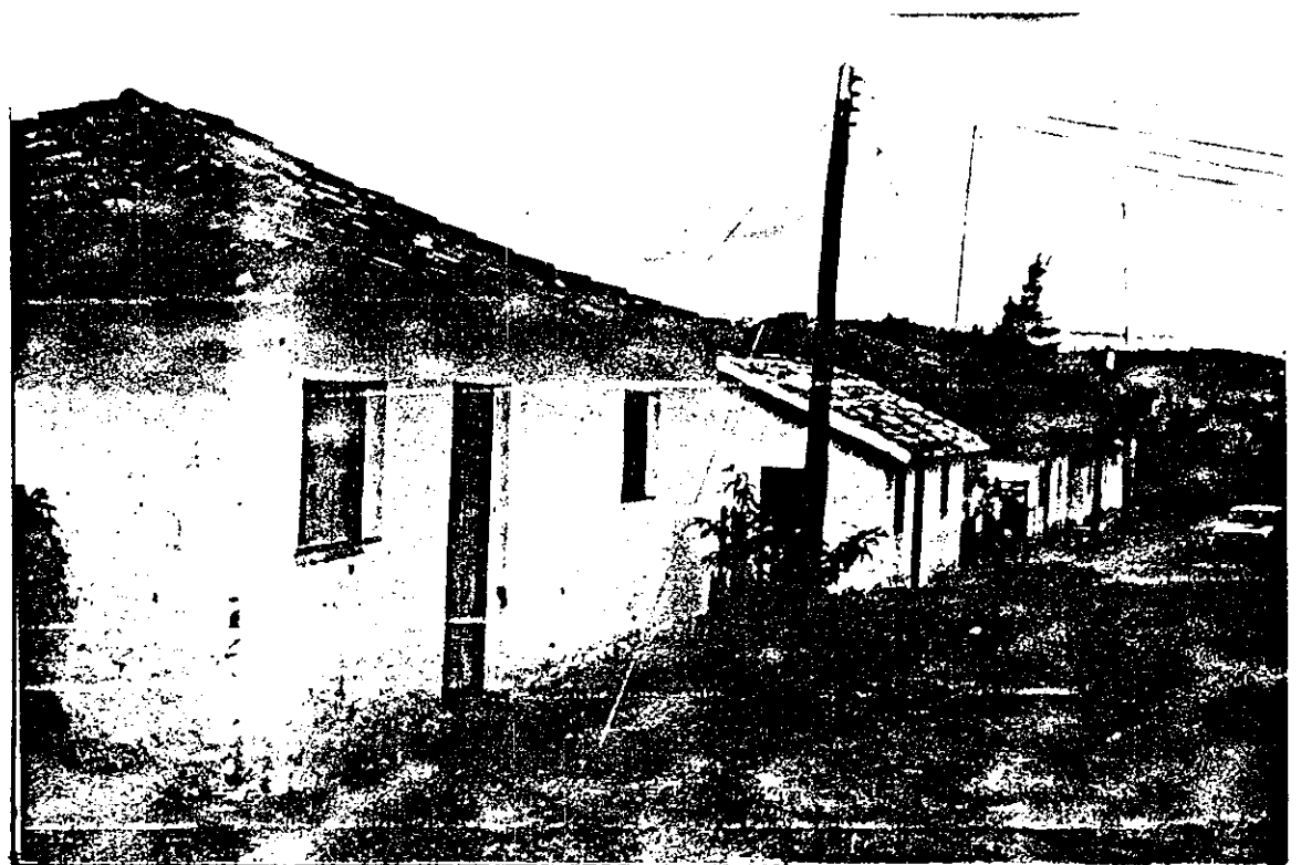
02 - Instalações da Funai - Posto água boa
