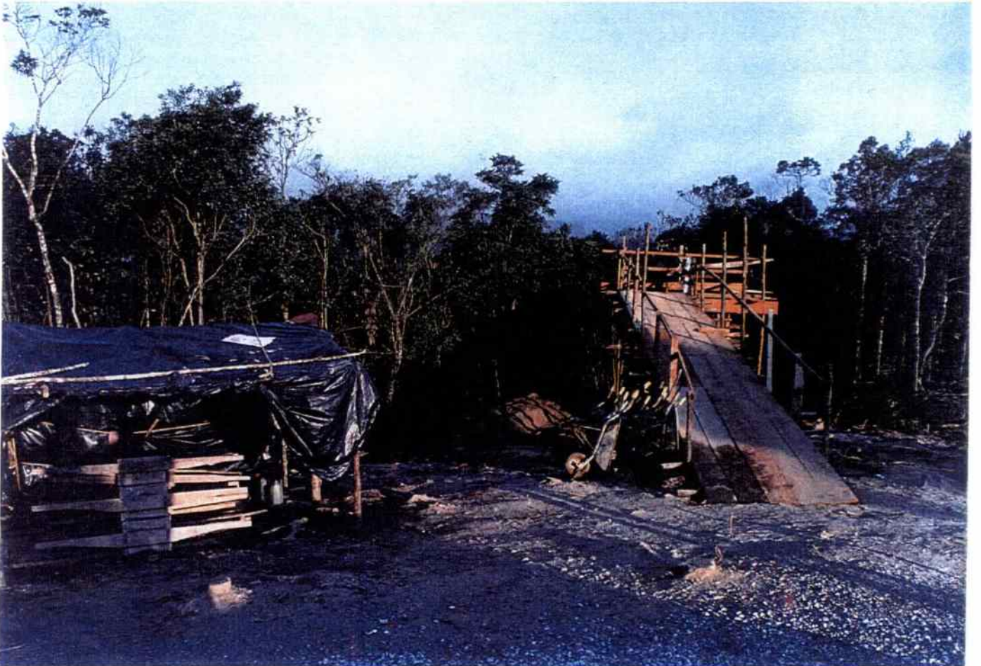
Locais das Torres 653 (acima) e 654
