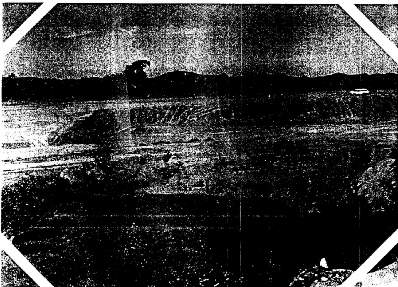
3) - Áreas de "Empréstimo" ME (margem esquerda) dentro da T. Indígena, de onde Furnas/Empreiteiras retiram material argiloso p/ compactação construção da Barragem. (Abaixo mesma descrição)
