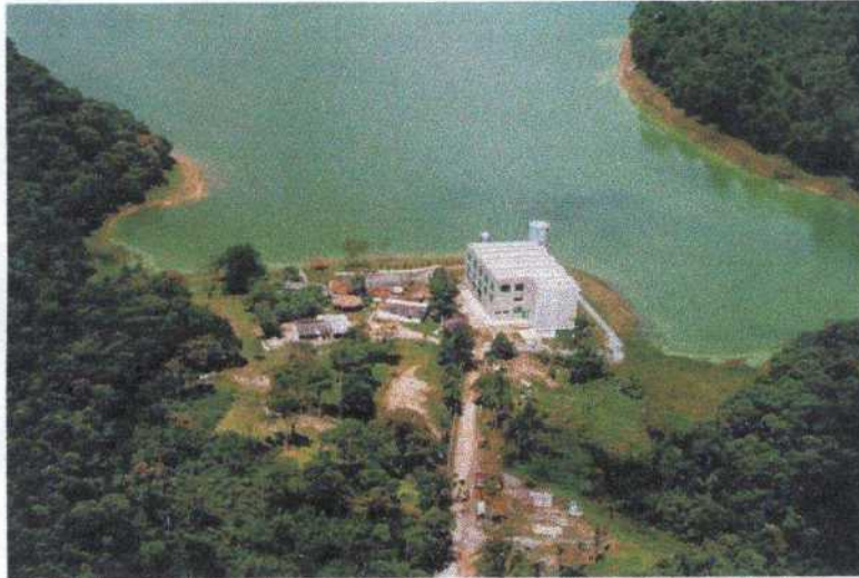
Foto 1 – Captação de água no Braço Taquacetuba (Represa Billings) Monica Monteiro Schroeder, 1999)
