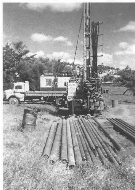
Abertura de poços artesianos em Montanha
