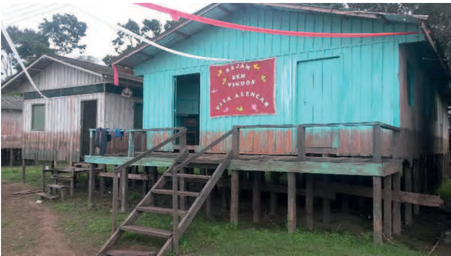
Figura 2: Casa comunitária da Vila Alencar, na parede fica visível o nível alcançado pela água em 2015. Fonte: DURAMAZ, 2005.
