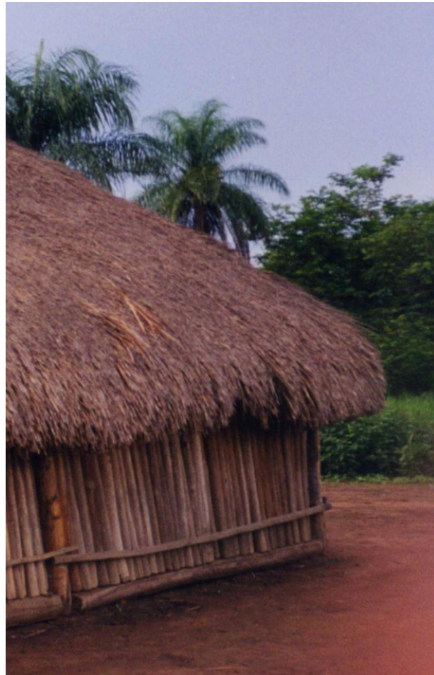
9. Parede (vista externa) e telhado de palha
