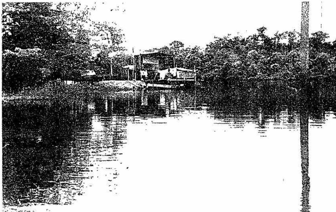
Figura 03. Flutuante Porto do Meio, à margem esquerda do Rio São Benedito
